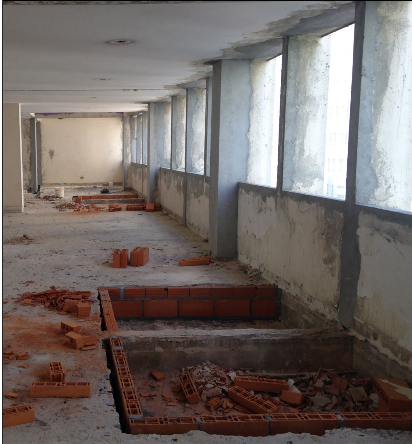
Novo andar tipo sendo preparado para construção dos quartos e nova escada metálica interna sendo montada.
