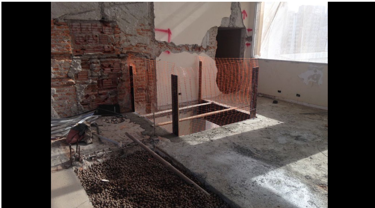
Novo elevador; reforço metálico na caixa do novo elevador; reforço da estrutura dos shafts; e reforço estrutural em todo o projeto.
